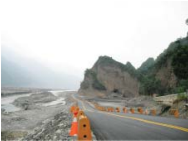
写真-1 河道内の仮設道路、土砂の堆積
