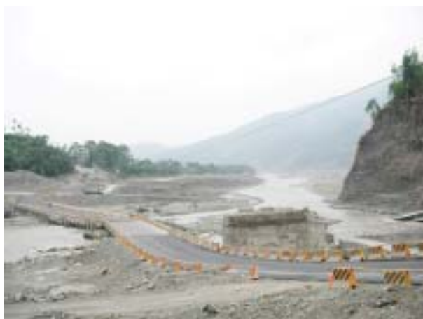
写真-2 流失した橋梁跡
