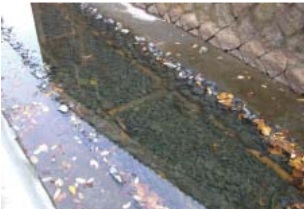
写真-4 木工沈床
