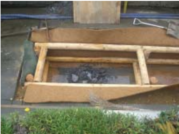
写真-3 木工沈床設置工事の様子
