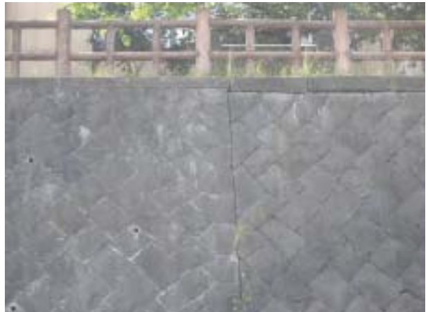
横手川の護岸に見られる施工の技の違い
