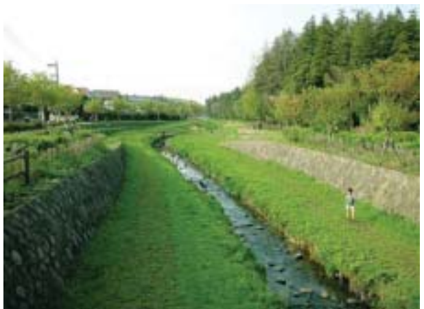
和泉川の再生された流れ(土木学会HPより)
