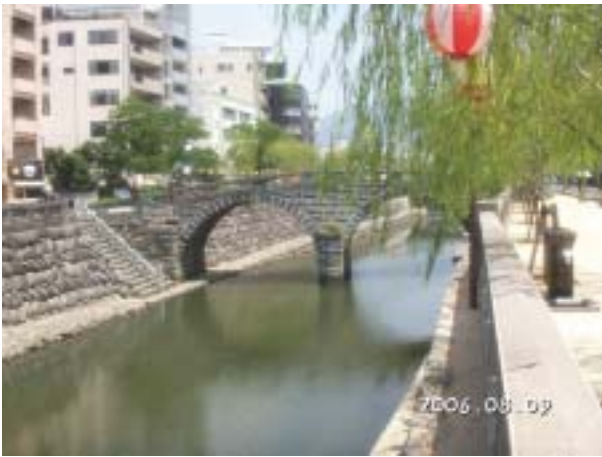
写真-6 原状復旧された長崎市中島川の眼鏡橋 2006年
