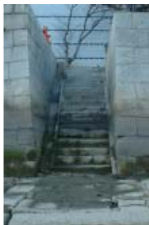
京橋川の護岸と雁木。精度の高い切込剥ぎは当時の石工の技術をうかがわせる 写真：土居郁夫
