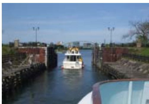
写真-4 重要文化財 横利根閘門通過(10/12)
