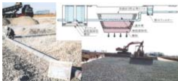
図-8 小中学校校庭の砕石空隙貯留浸透施設
