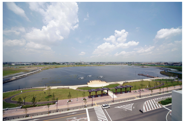
写真-1 越谷レイクタウン大相模調節池（地区北側水面全景）
