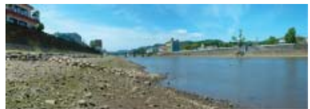
写真10 護岸覆土による水際確保
