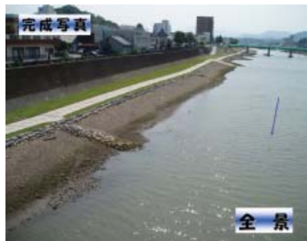
写真9 工事完成写真
