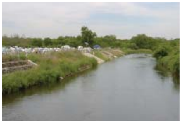
岐阜県で実施されている「自然の水辺復活プロジェクト」の自然共生工法展示場(現場での研究)風景
