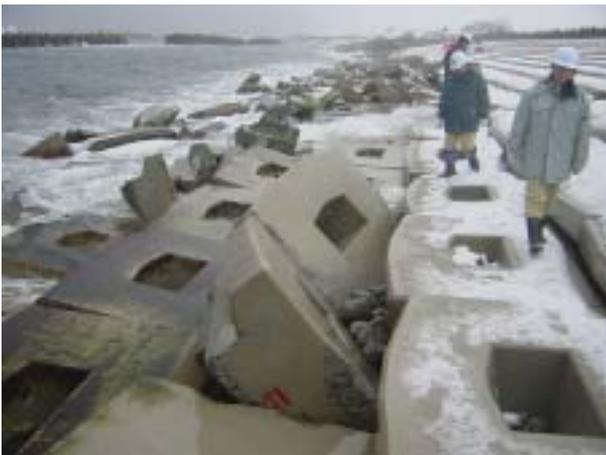
写真 - 3 風浪で被災した護岸
