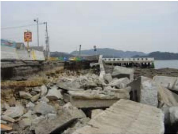
写真 - 2 台風で崩壊した堤防
