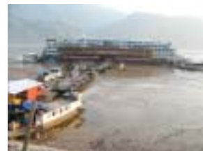
ダム湛水区間(土砂の堆砂状況)
