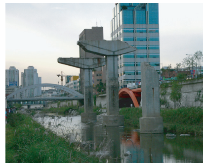
写真-6 残された橋脚
