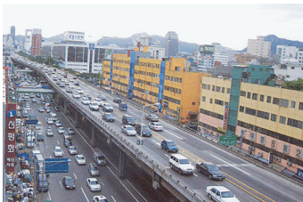
写真-2 覆蓋化された清溪川
