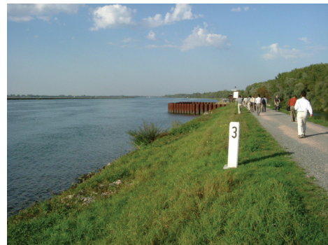
写真-2 満々と水をたたえるライン川、矢板で囲われている箇所がポルダーへの流入部
