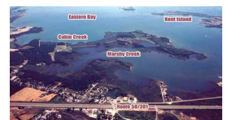
写真-4 10個の修復プロジェクト
