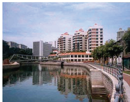
写真-2 再生後のシンガポール川
