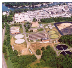
写真-2 下水処理施設
