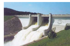
写真-4 南部のダム
