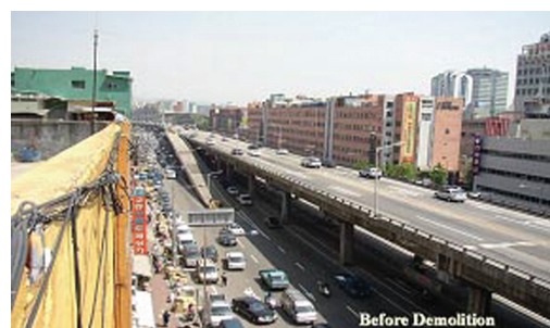
写真-1 再生前の清溪川と高速高架道路
