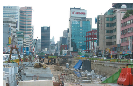
写真-3 整備の進む清溪川復元工事
