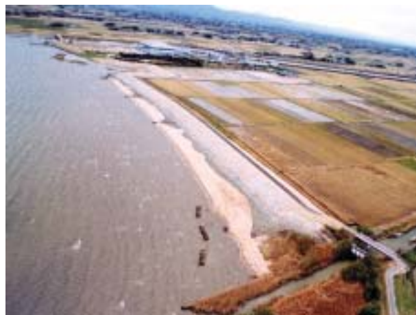
写真-4 整備後の航空写真
