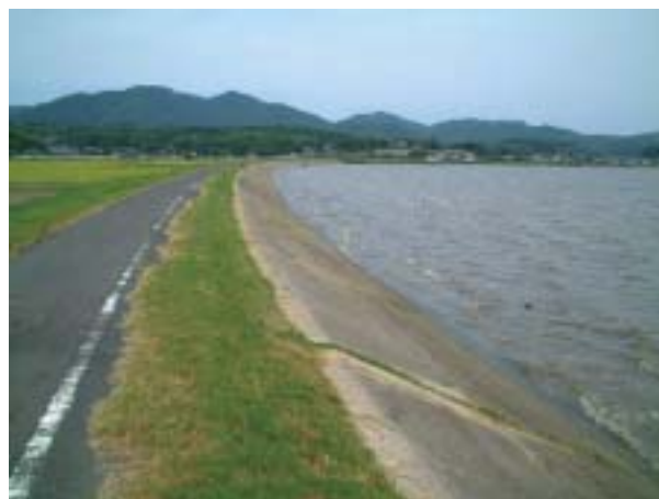
写真－2 宍道湖のコンクリート護岸
