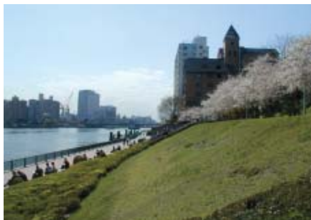
写真-2 中央区明石地区(聖路加病院)付近
