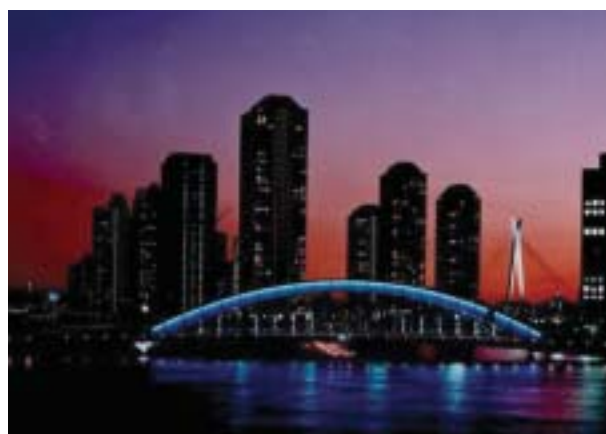
写真-3 永代橋を隅田川上流側から望む
