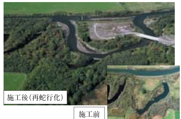
写真-6 自然再生事業の事例（標津川の再蛇行区間） 直線区間にほとんどみられなかった大型のサクラマス等が再蛇行区間にできた淵や倒木の陰で確認されている。
