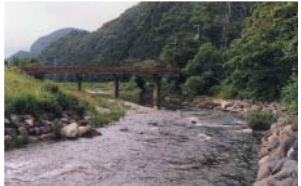
写真-5 多自然型川づくりの事例（八東川） 旧河道を活用して流下能力向上を図るにあたり、瀬や淵などがある川らしい景観を復元した。
