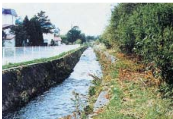
写真－1 積みブロック三面張り護岸の河川改修
