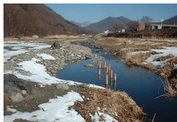
木曾川水系木曾川(長野県木祖村)
