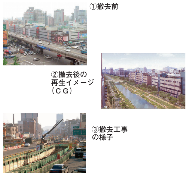
写真-1. 韓国の再生事例（チョンゲチョン清溪川）高架高速道路を撤去し川を再生。将来的には沿川の再開発も進め、アジアの中心として活気あふれるソウルの中心地区とすることを目指している事例。
