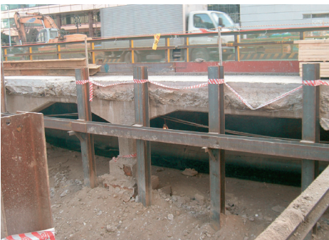
写真-2 現在の工事実施状況
