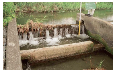
魚道機能が良好でない施設例
