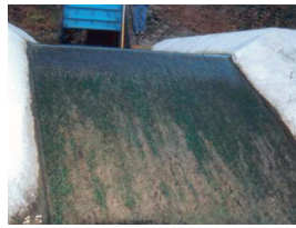
北川との落差 230cm (河口から13.7kmの排水樋門)
