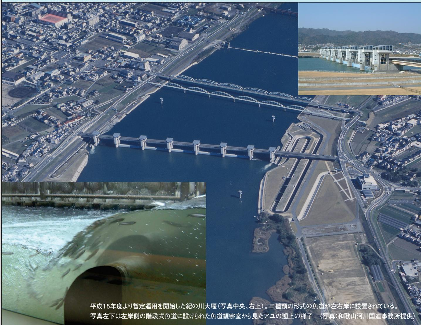
平成15年度より暫定運用を開始した紀の川大堰(写真中央、右上)。三種類の形式の魚道が左右岸に設置されている。
