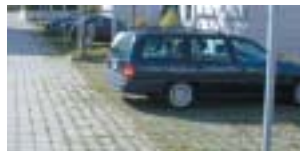
透水性の駐車場舗装
