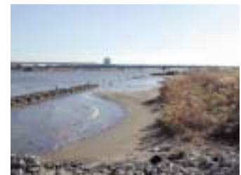
小松川地区試験施工現場
