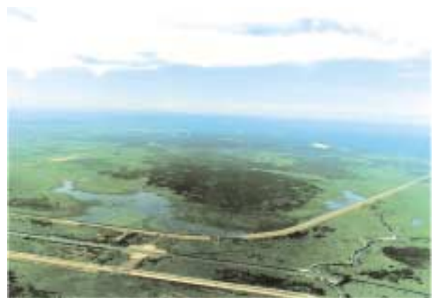
写真－2 雪裡樋門湛水試験
