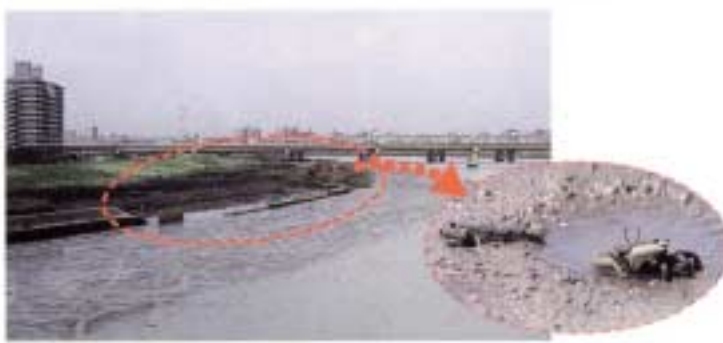
図一 4 既設護岸の改良による干潟環境の復元 (荒川)
