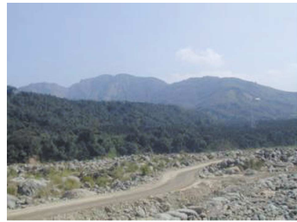
写真-3 現場風景 (上流側) : 山間部においては、荒廃が進んでおり、今後新たな土石流の発生が心配される。
