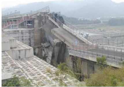
写真一5 被災した石岡ダム：この写真を見てもわかるように、台湾地震の凄まじさが分かる。地震時には、9mもの隆起が起こった。
