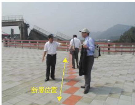
写真一7 断層位置：タイルの色が違うところが断層。
