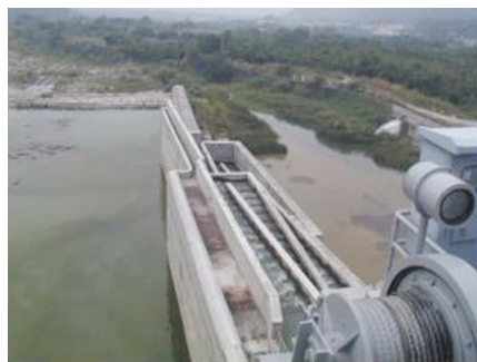
写真一6 新たに設置された魚道：被災後1扉門を魚道として改良し、河川の連続性を確保している。
