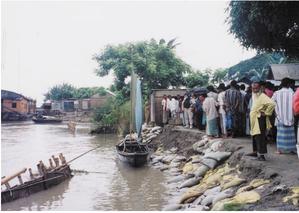
写真一五 洪水で侵食された川港 (ブラマプトラ(ジャムナ)川)
