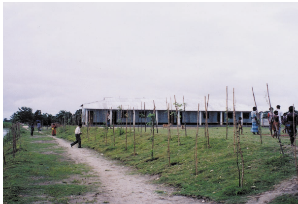
写真三 チャールに整備された学校兼避難場所 (浸水しないよう盛土されている)
