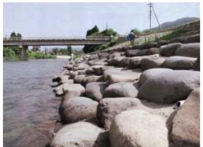
写真 - 2 隙間のない巨石護岸（水生生物も住めない）
