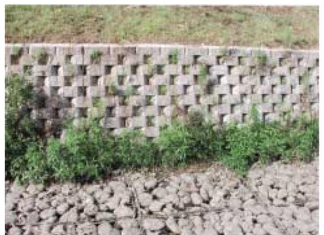
写真 - 3 田園地域の植生護岸とフトンカゴ（水枯れ・埋没表流水）
