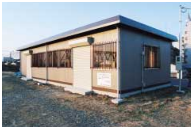
写真-1 アメニティ施設 利根川(茨城県取手市): 利根川サイクルステーション
