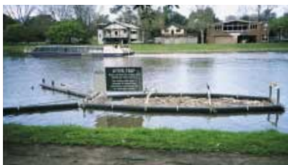
写真 - 1 浮遊タイプのゴミ収集装置 (サインには「道路を汚すと川が汚れる」主旨の解説がある。)
