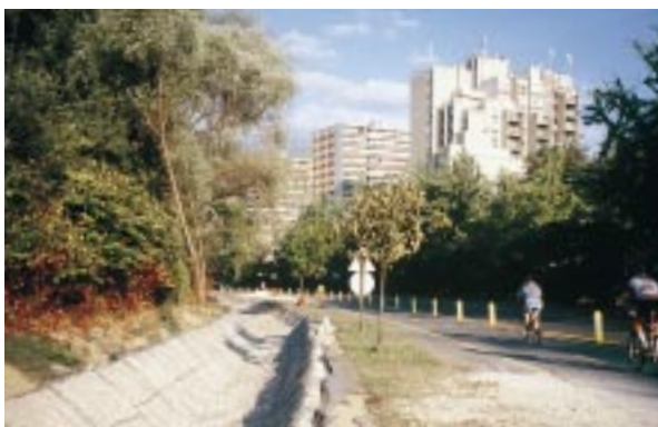
写真 - 3 施工中のピエーヴル川
