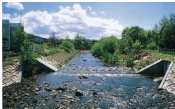
写真-3 改修済区間
