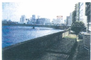
写真-1・2 隅田川のコンクリート壁(パラペット堤防)とまち並み
