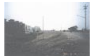
写真 - 1・26 荊江大堤防(堤防上は道路)
