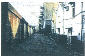
写真-1・3 隅田川のコンクリート壁(パラペット堤防)とまち並み(その2)
