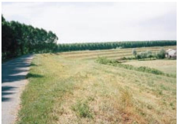
写真-1 堤防(堤内側)の状況。幾つかの小段を経て、平均勾配6割で堤内地に続く。左は栽培されているポプラの人工林。
