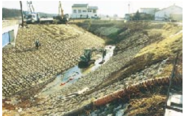
写真6 2割勾配の護岸を有し低水路幅が狭い河道の事例1
