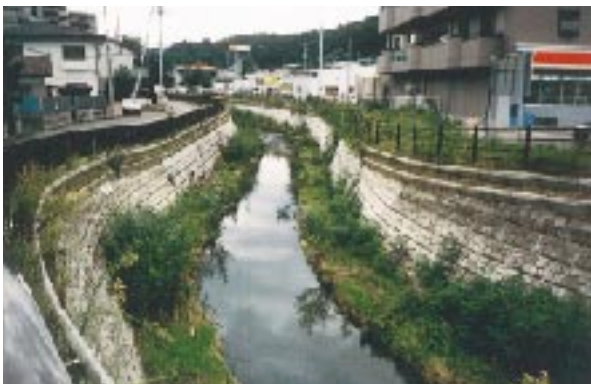
写真12 急勾配の護岸を有する河道の水際の工夫2
