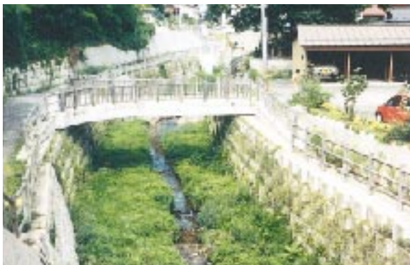
写真11 急勾配の護岸を有する河道の水際の工夫1
