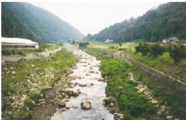
写真17 急流河川での急勾配の護岸を有する河道での工夫 2
