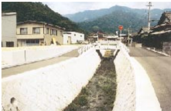
写真1 急勾配の護岸を有する矩形断面の河道の事例1
