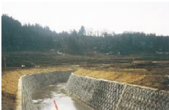
写真2 急勾配の護岸を有する矩形断面の河道の事例2
