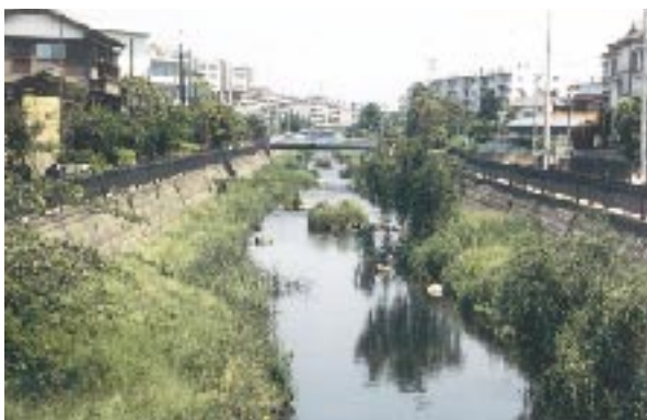
写真18 都市河川での急勾配の護岸を有する河道での工夫
