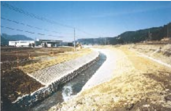
写真4 水際の急勾配の複合勾配の護岸を有する河道の事例1
