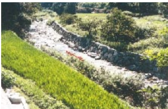
写真16 急流河川での急勾配の護岸を有する河道での工夫 1
