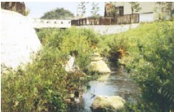
写真13 急勾配の護岸を有する河道の水際の工夫（都市河川）
