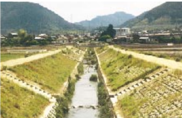
写真5 水際の急勾配の複合勾配の護岸を有する河道の事例2
