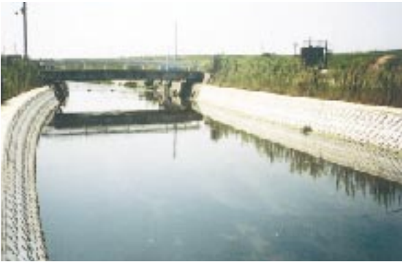
写真3 急勾配の護岸を有する矩形断面の河道の事例3
