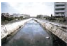
改修前の蛇行低水路の完成後 改修前の蛇行ピッチを参考にして、低水路を蛇行させた。(昭和59年8月)
