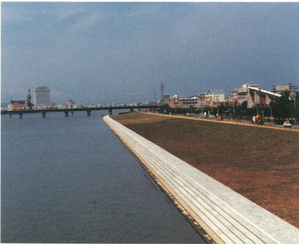
緩勾配(5割)堤防の整備により水辺へのアクセスを高めた例(新潟県、信濃川)
