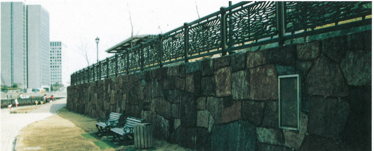
彩度が高く、少し不自然ではあるが、形状、パターン、テクスチャー、目地などのデザインに配慮したコンクリート護岸。
