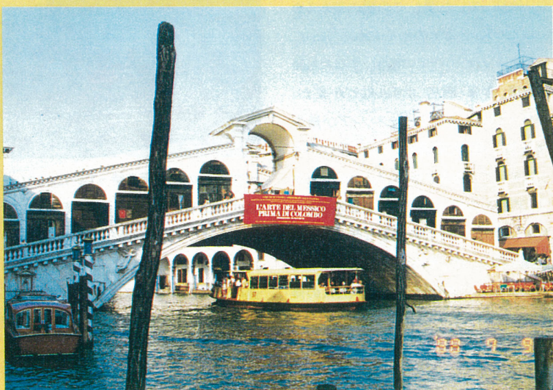
リアルト橋の現況
