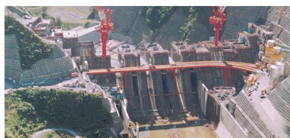
写真-2 施設による適応策 ダム
