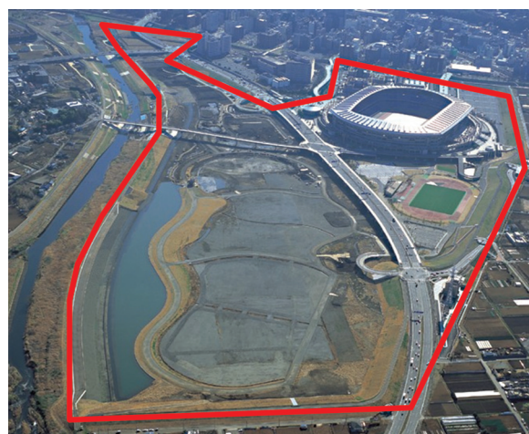
写真-3 施設による適応策 遊水池
