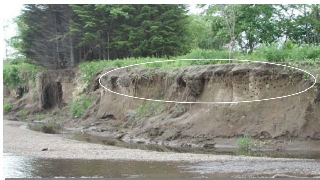
鳥類（ツバメ、カワセミ等）は、洪水による侵食部分を営巣に利用することがある
