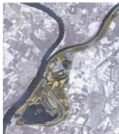
図 6. [事例 1]のレーンワーデン市にある 氾濫原の空中写真(復元以前の状況)
